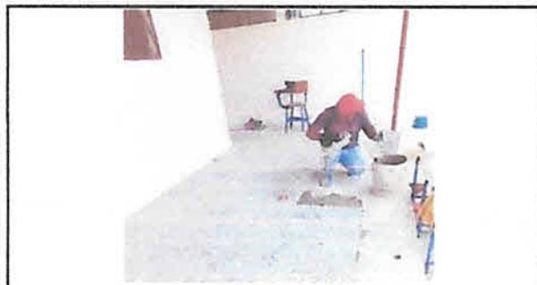
Foto 3: reparación de piso de cemento líquido a piso de granitos a modulo A y B y corredor 1
